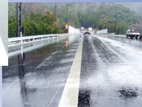
散水管(保護コンクリート巻)配管
