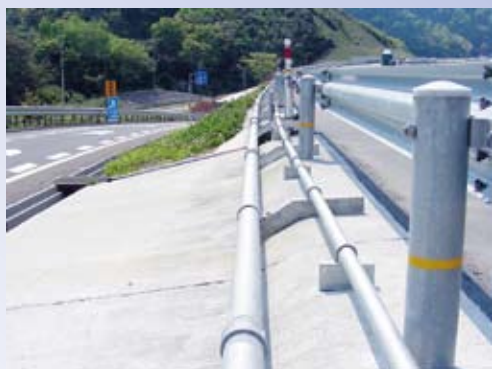
送・散水管布設状況
