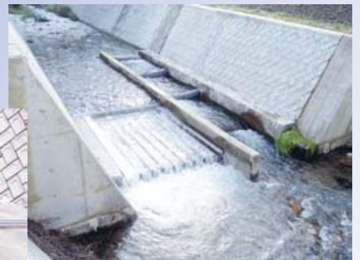
河川設置状況
