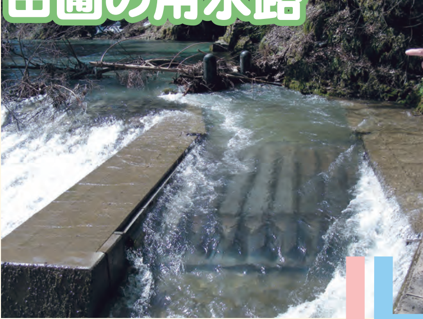
河川設置状況
